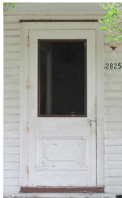
Porte en bois à menuiserie d'assemblage. 2825, rang du Grand-Saint-Esprit. IMG_0657.jpg
