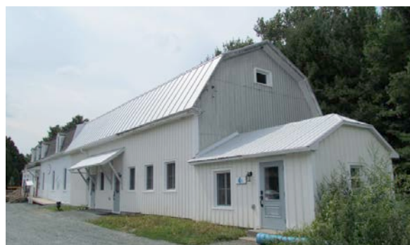
L'ancienne écurie des Pères Monfortains vue de l'arrière. BIMG_0354.jpg
