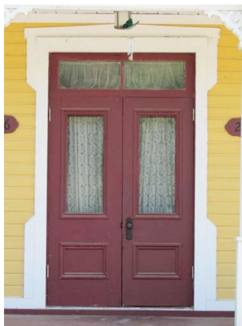
Porte en bois à doubles battants à menuiserie d'assemblage. Une imposte et des chambranles encadrent le tout. 232-240, rue de Monseigneur-Signay. IMG_0470.jpg
