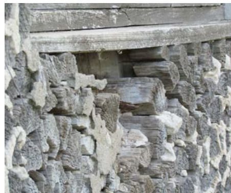
Autre détail de la structure en billes sur billes de l'ancienne porcherie de la ferme du séminaire de Nicolet. IMG_2044.jpg
