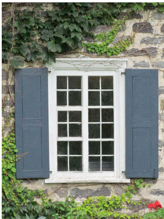
La fenêtre à 24 petits carreaux, le modèle typique de fenêtre des maisons associées à l'architecture d'inspiration française. Celle-ci est particulièrement bien préservée au 289, route Marie-Victorin. BIMG_0654.jpg
