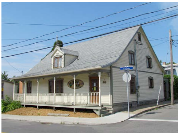
Un exemple de bâtiment principal, le 389, rue Notre-Dame. IMG_0577.jpg
