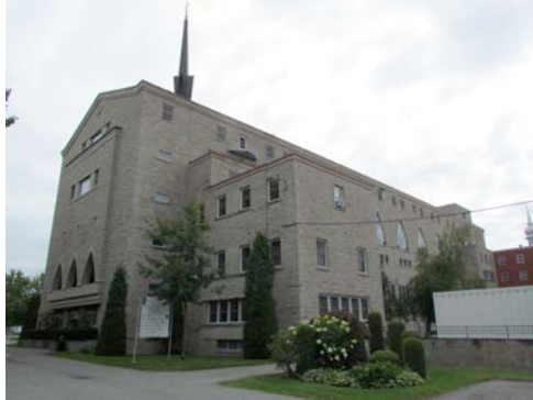
La chapelle des Sœurs de l'Assomption de la Sainte Vierge. Construit entre 1955 et 1962, l'imposant édifice a été conçu selon les plans de l'architecte J. David Deshaies.
