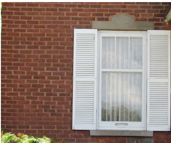
Modèle relativement peu courant de fenêtres à guillotine à petits-bois. 3700, rang des Soixante. IMG_1999.jpg
