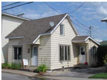
Valeur patrimoniale : Faible
