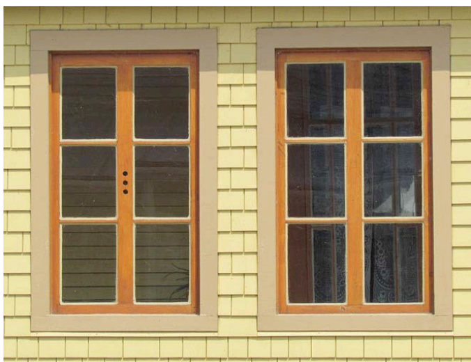
Exemple de contre-fenêtres à battants à six grands carreaux, en usage sur un solarium au 551, rue Saint-Jean-Baptiste. BIMG_0262.jpg
