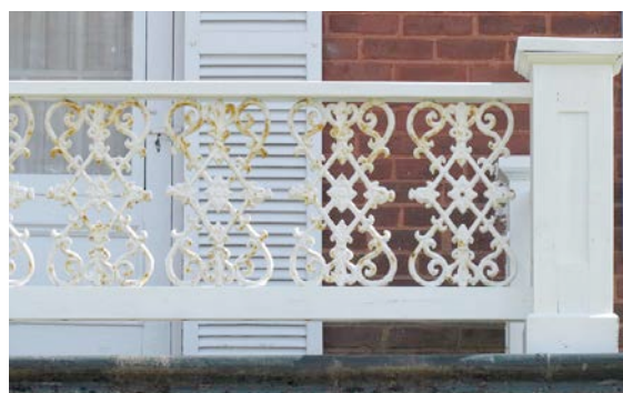
Un autre modèle de fonte moulée sur le garde-corps de balcon du 3700, rang des Soixante. IMG_1998.jpg
