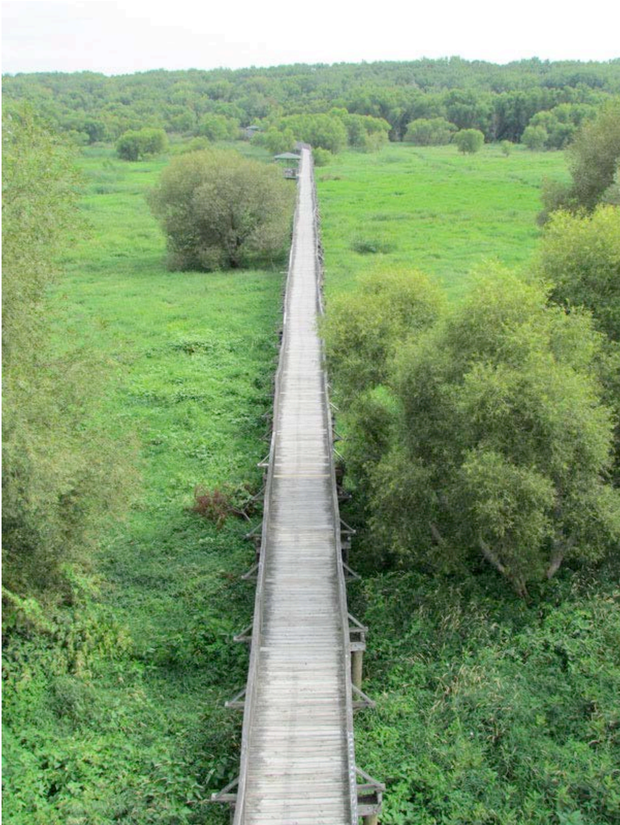
La passerelle sur pilotis du parc de l'Anse du Port. D'une longueur de 2300 pieds, elle permet de traverser le marais et de se rendre jusqu'à la rive du fleuve, à proximité du phare de Nicolet.
