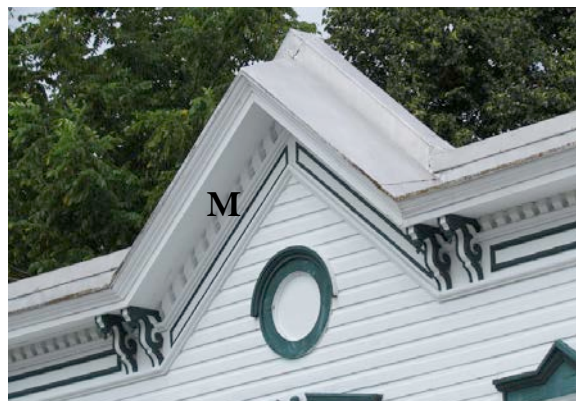
Fronton avec à sa base des consoles; des modillons (M) rythment l'intérieur de la corniche. 391, rue de Monseigneur-Plessis. IMG_0248.jpg
