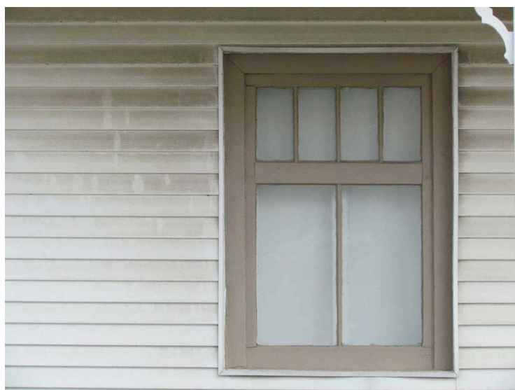
Exemple de fenêtre à battants dont l'imposte est à petits-bois. 410, rue de Monseigneur-Panet. IMG_0353.jpg
