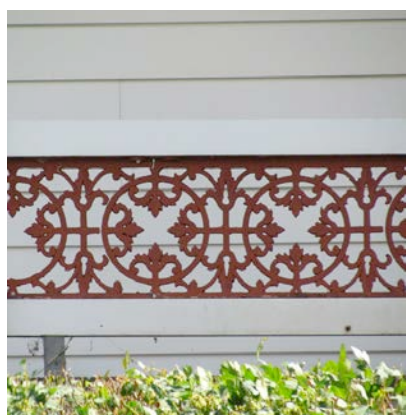
Modèle très orné de garde-corps en fonte moulée, vraiment très rare. 1820, route Marie-Victorin. BIMG_0543.jpg
