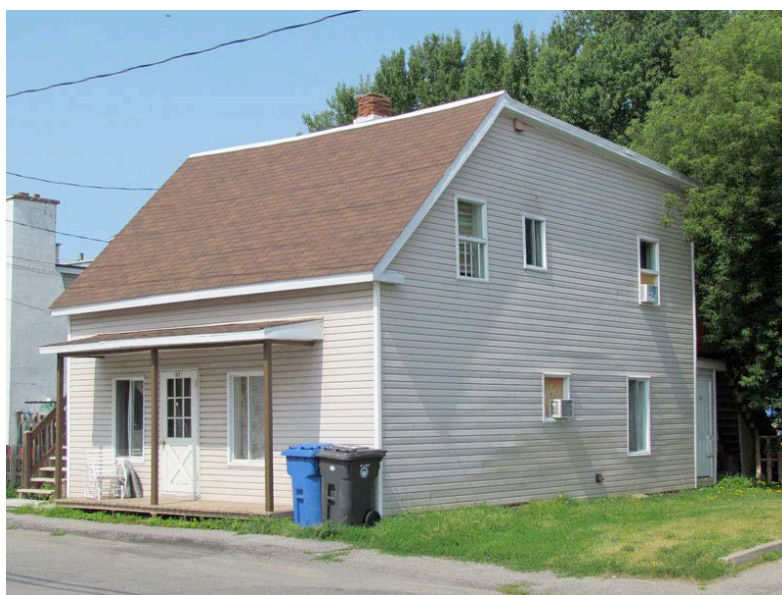
Exemple d'édifice ayant subi une modification assez importante relative à sa volumétrie. 429-433, rue de Monseigneur-Panet. IMG_0089.jpg
