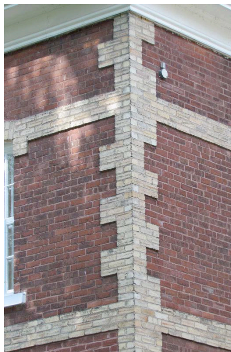
Chaîne d'angle et bandeau en brique de l'ancien palais de justice. IMG_0926.jpg
