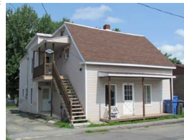
Valeur patrimoniale : Faible
