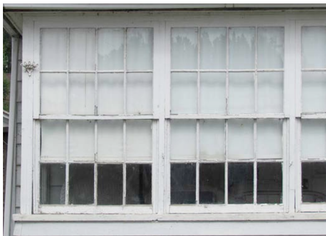
De telles fenêtres à guillotine à petits carreaux, en usage sur les solariums, tendent de plus en plus à disparaître. Celles-ci sont très bien préservées. 1759, rue Saint-Jean-Baptiste. BIMG_0390.jpg
