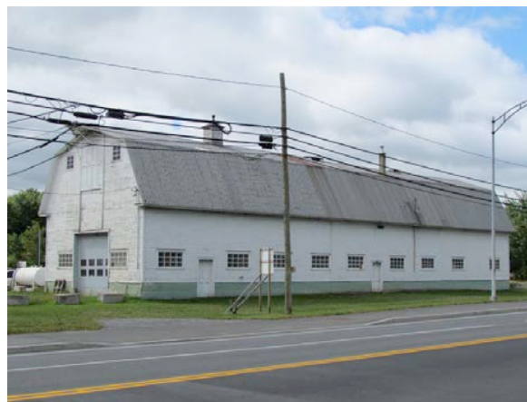
Exemple d'un édifice « hors type », l'ancienne grange-étable du Séminaire au 3220, boulevard Louis-Fréchette. BIMG_0797.jpg
