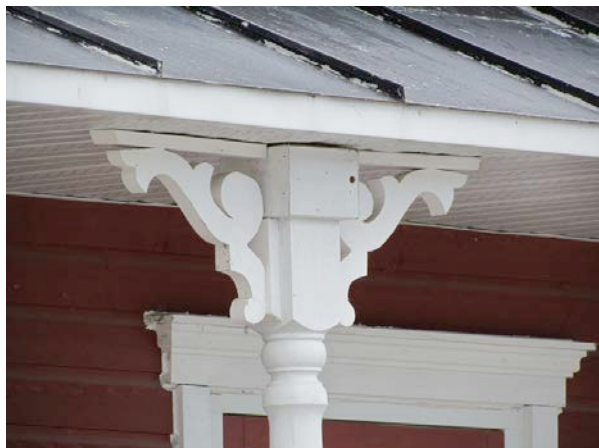
Aisselier de chaque côté du sommet d'une colonne. Qu'il soit restauré ou d'origine (mais probablement issu d'une restauration), c'est un fort beau modèle. 124, rue de Monseigneur-Plessis. IMG_0137.jpg
