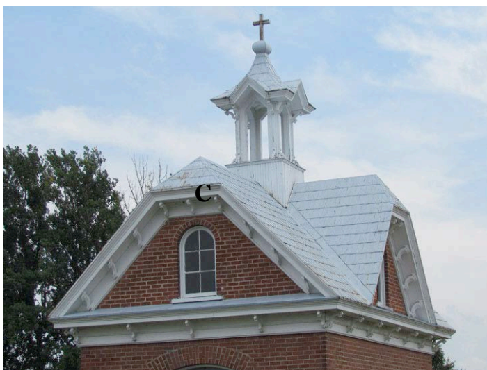
Le fronton à croupe (C) et la lucarne du même genre sont extrêmement rares pour ce genre d'édifices. Il en est ainsi pour l'éclairage des combles par des fenêtres hautes en arc plein cintre. Le clocheton ouvragé n'est pas en reste par sa qualité. 675, rue Saint-Jean-Baptiste. BIMG_0301.jpg
