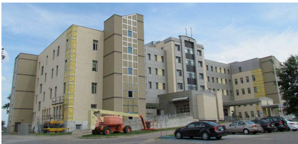
Le Centre Christ-Roi en 2014. D'importantes rénovations ont été effectuées sur le bâtiment, qui a perdu la quasi-totalité de ses composantes et matériaux d'origine. 675, rue Saint-Jean-Baptiste. BIMG_0287.jpg
