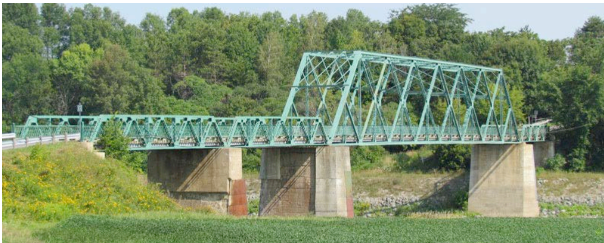
Le pont Taschereau du rang de l'Île, érigé en 1916. Ce pont, qui jumelle les assemblages et les poutres appelés Warren et Pony-Warren, est le seul du genre au Québec. IMG_2030.jpg
