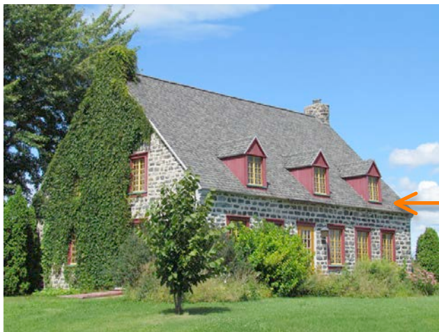
Maison Jean-Baptiste-Proulx, 2263, rang des Soixante. Le toit en forte pente, la structure de pierre et des éléments décoratifs, comme les corbeaux, permettent de l'associer à l'architecture d'inspiration française. IMG_1941.jpg
