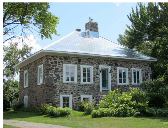
Le 3560, rang des Soixante en 2014. Les nouvelles fenêtres, s'apparentant au modèle original à battants à grands carreaux, s'intègrent très bien à l'édifice. IMG_1985.jpg
