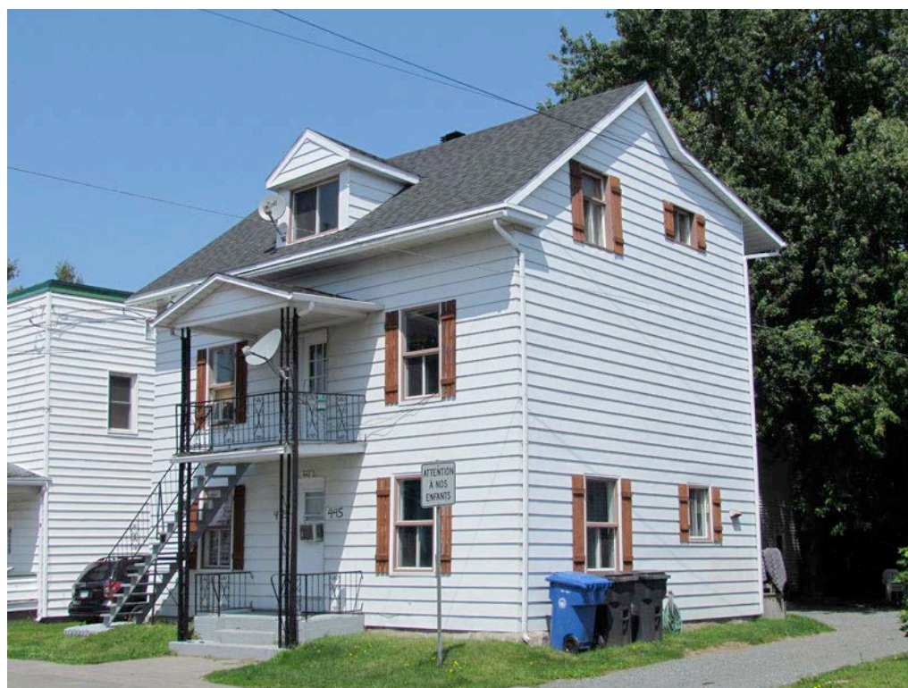
Édifice offrant une mauvaise valeur d'authenticité et ayant connu des transformations en ce qui a trait aux revêtements, ouvertures et composantes décoratives. En outre, le versant arrière du toit a été modifié. 445, rue de Monseigneur-Plessis. IMG_0434.jpg
