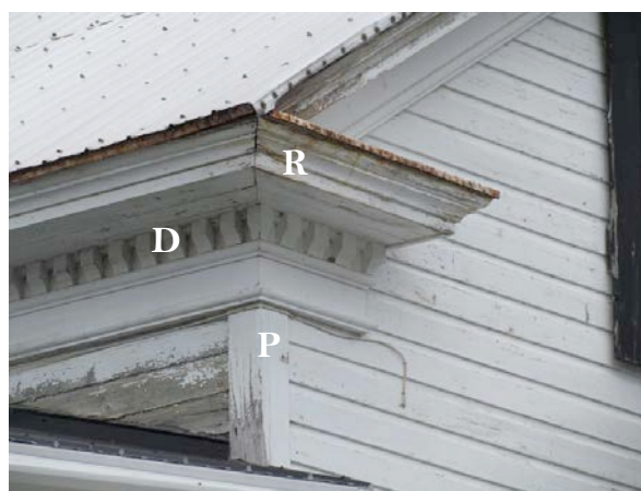
Retour (R) de corniche, denticules (D) et extrémité d'une planche cornière (P). À voir au 277, rue Léon-XIII. IMG_0207.jpg
