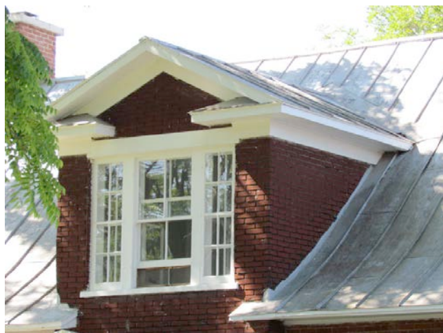
Modèle de lucarne à fronton rarement utilisé sur ce genre d'édifice érigé en 1824 (une maison traditionnelle québécoise). Elle est éclairée par une fenêtre à guillotine à grands carreaux encadrée de baies latérales. Maison des Caron, 420, rue Saint-Jean-Baptiste. IMG_1761.jpg
