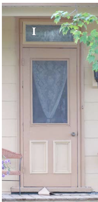
Porte en bois à menuiserie d'assemblage avec imposte (I) sise au 3400, boulevard Louis-Fréchette. BIMG_0792.jpg
