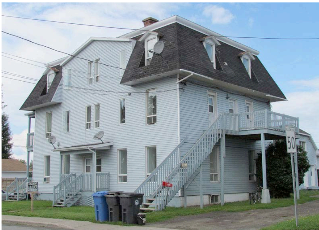
Le 379-387, rue Saint-Jean-Baptiste en 2014. La magnifique toiture, les chambranles de fenêtre, la logette au-dessus des portes, la lucarne d'origine et les murs de pierre ne sont plus perceptibles. IMG_1563.jpg
