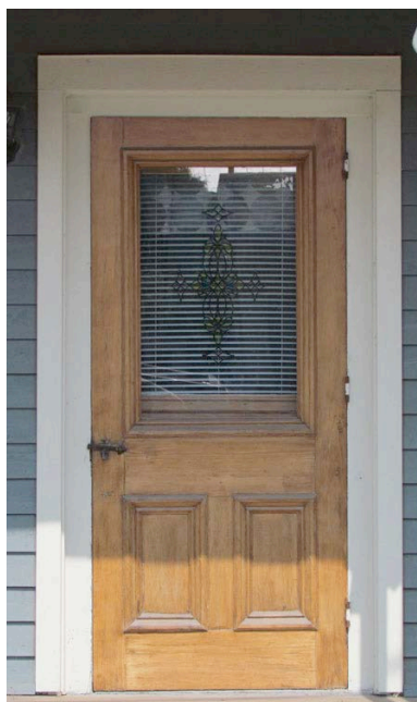
Exemple d'une porte en bois, à panneaux et vitrage. 373, rue de Monseigneur-Panet. IMG_0081.jpg
