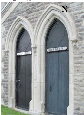
Fines nervures (N) à arc ogival en pierre de taille supportées par des piédroits en même matériau. BIMG_0322.jpg
