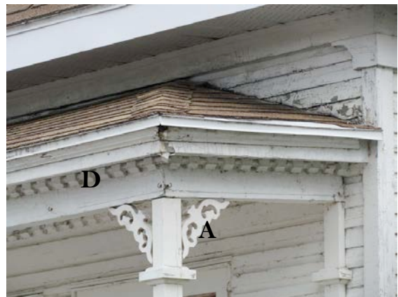
Aisseliers (A) et denticules (D), des composantes décoratives sur un édifice de prime abord modeste, le 192, rue du Curé-Fortier. IMG_0191.jpg
