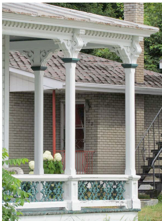
Colonnes supportant des aisseliers très ornés sur lesquels s'appuient des consoles. Il s'agit d'une intéressante façon de faire récurrente à Nicolet et dans certaines municipalités voisines. Le garde-corps est constitué d'éléments en fonte moulée. 391, rue de Monseigneur-Plessis. IMG_0262.jpg
