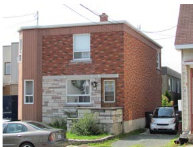
Valeur patrimoniale : Faible
