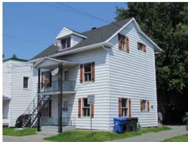
Valeur patrimoniale : Faible
