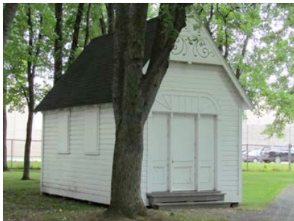
Exemple d'architecture religieuse, la chapelle des Sœurs de l'Assomption de la Sainte Vierge au 251, rue Saint-Jean-Baptiste. BIMG_0991.jpg
