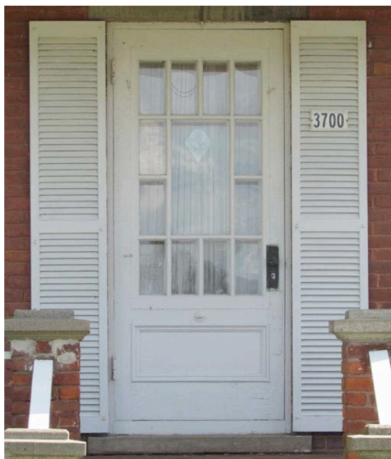
Porte probablement d'origine du 3700, rang des Soixante, érigé vers 1935. Une moitié inférieure à caissons et un vitrage à petits-bois, typiques de la période de construction de l'édifice. IMG_2000.jpg
