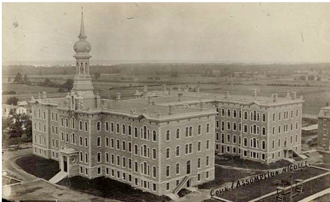
Le couvent ou maison mère des Sœurs de l'Assomption de la Sainte Vierge, peu de temps après sa construction survenue entre 1906 et 1908. 225, rue Saint-Jean-Baptiste. BAnQ, CP 3938. St-Jean-Baptiste, 225, Couvent SRS Assomption, BAnQ, CP 3938.jpg
