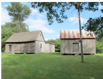
Exemple d'un édifice «hors type», l'ensemble agricole au 515, rang Saint-Alexis. IMG_1374.jpg
