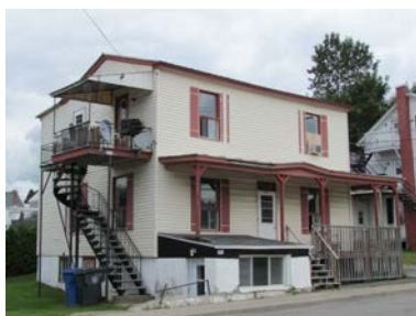
Valeur patrimoniale : Faible
