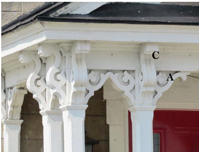
Aisseliers (A) et consoles (C) au sommet des colonnes du 124, rue de Monseigneur-Plessis. IMG_0026.jpg
