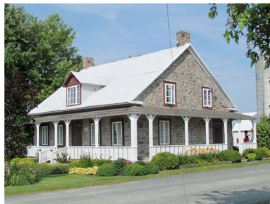
Le 3695, boulevard Louis-Frédéric en 2014. Seules les fenêtres de l'étage ont été changées. Un intéressant garde-corps a en outre été mis en place. BIMG_0167.jpg
