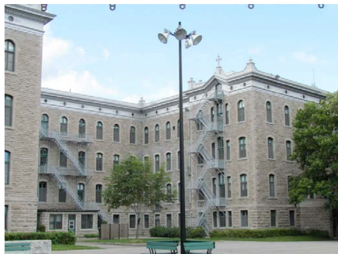
La façade sud-est de l'ancien couvent en 2014. 225, rue Saint-Jean-Baptiste. BIMG_0766.jpg
