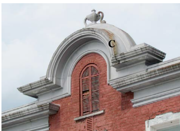
Imposant couronnement (C) ou fronton en arc plein cintre avec à sa base une corniche moulurée. C'est le seul exemple du genre à Nicolet. 391, rue de Monseigneur-Plessis. IMG_0286.jpg
