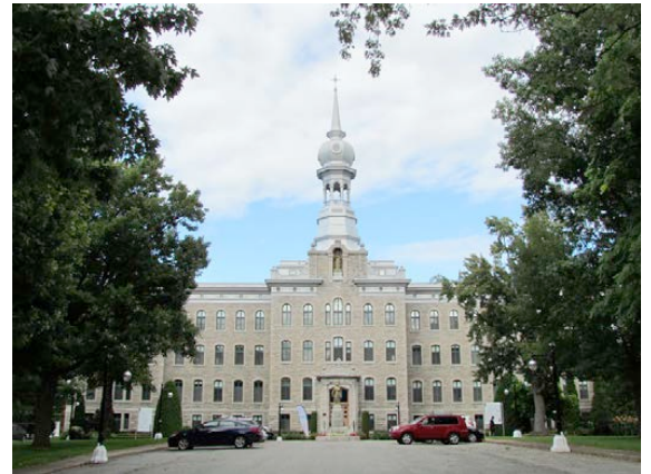
Exemple d'architecture conventuel, l'ancien couvent des Sœurs de l'Assomption de la Sainte Vierge au 225, rue Saint-Jean-Baptiste. BIMG_0737.jpg
