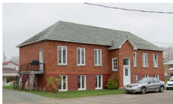
Le 227, rue Paul-Émile-Lamarche en 2014. La quasi-totalité des fenêtres à guillotine ont été remplacées par des fenêtres à manivelles à ouverture extérieure. En outre, un revêtement de type moderne a été mis en place au rez-de-chaussée. IMG_1403.jpg
