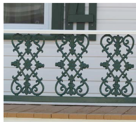
Modèle de garde-corps en fonte moulée identique à celui de la photo ci-haut. 184, rue de Monseigneur-Signay. IMG_0491.jpg
