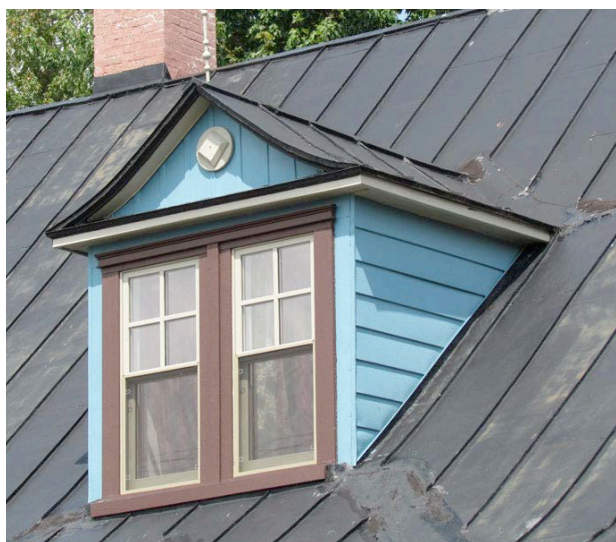
Exemple de lucarne à fronton, peu fréquente avec ses fenêtres doubles. 533, rue Saint-Jean-Baptiste. BIMG_0250.jpg
