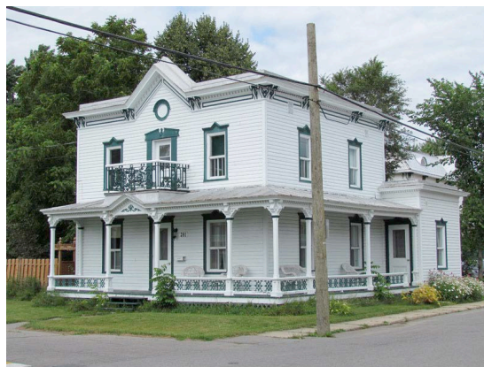
Exemple d'habitation à toit plat, le 391, rue de Monseigneur-Plessis. IMG_0246.jpg
