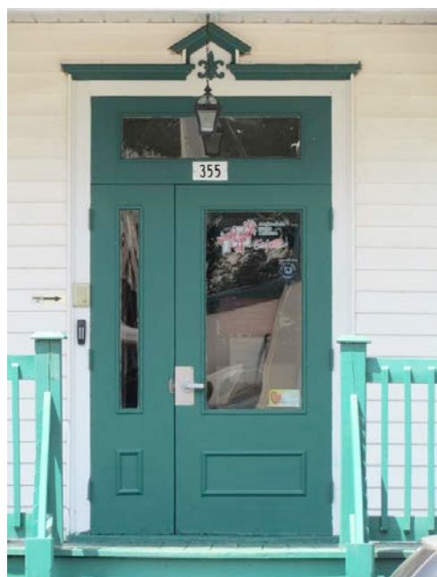
Exemple d'une porte en bois, à panneaux et vitrage, avec baie latérale et imposte. 355, rue de Monseigneur-Signay. IMG_0404.jpg
