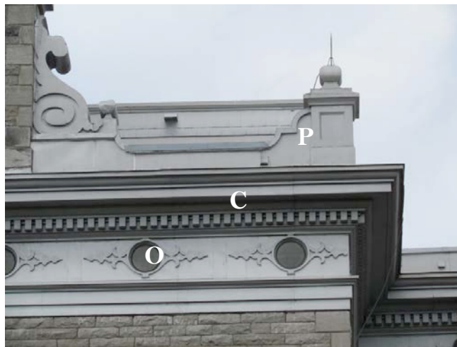
Imposante corniche à modillons (C) percée d'oculus (O) et surmontée d'un mur parapet (P) très orné. Ancien couvent des Sœurs de l'Assomption de la Sainte Vierge. 225, rue Saint-Jean-Baptiste. BIMG_0758.jpg
