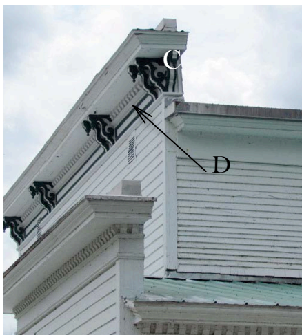
Aisselier de chaque côté du sommet d'une colonne. Qu'il soit restauré ou d'origine (mais probablement issu d'une restauration), c'est un fort beau modèle. 124, rue de Monseigneur-Plessis. IMG_0137.jpg
