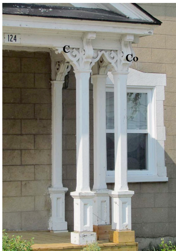
Porche doté d'imposantes colonnes sur socle à chapiteau (C) corinthien (Co) et ornées de larges consoles. 124, rue de Monseigneur-Plessis. IMG_0027.jpg
