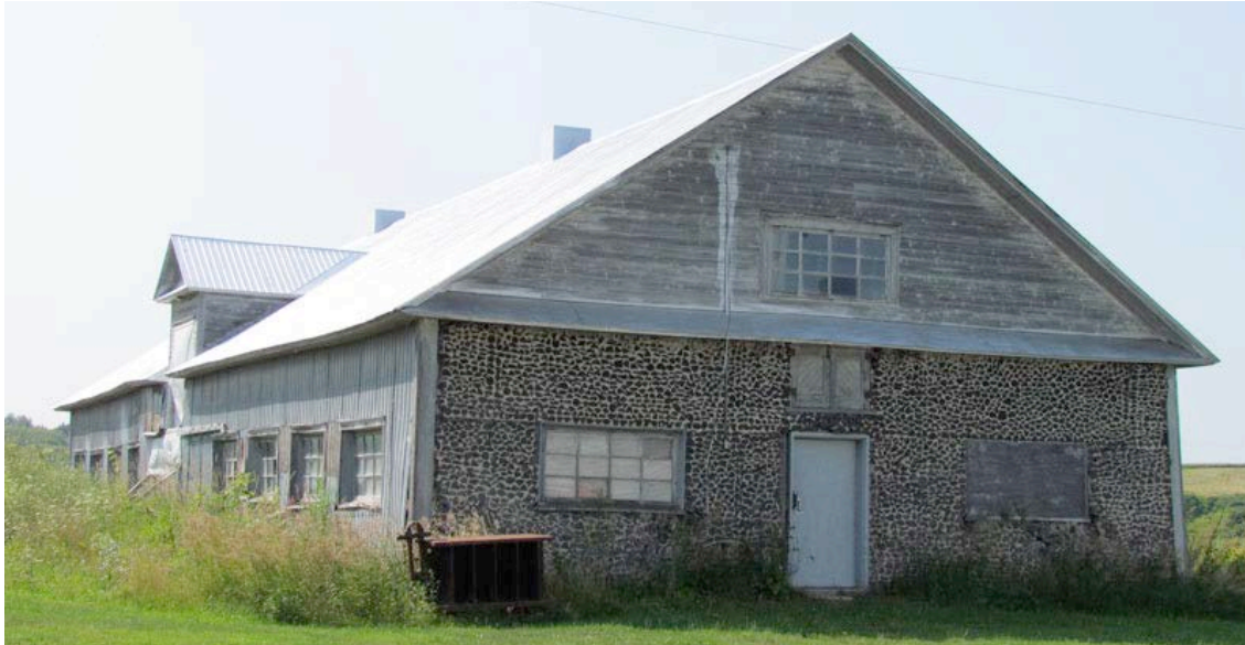
Une ancienne porcherie, l'un de trois bâtiments qui composent la ferme du séminaire de Nicolet, érigée au cours des années 1930. Sa structure est en billes sur billes, aussi appelée en bois cordé. 1600, rang de l'Île. IMG_2035.jpg
