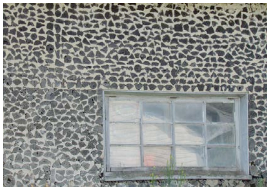
Détail de la structure en billes sur billes de l'ancienne porcherie de la ferme du séminaire de Nicolet. 1600, rang de l'Île. IMG_2036.jpg
