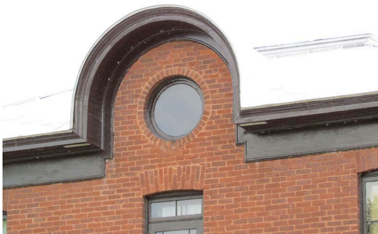
Très rare modèle de lucarne en arc plein cintre éclairé par un oculus. 380, route Marie-Victorin. BIMG_0618.jpg
