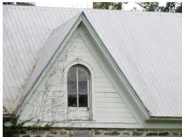
Lucarne épousant la forme d'un gable, une forme de lucarne peu usuelle pour ce genre d'édifice érigé au début du 19 e siècle. 280, route Marie-Victorin. BIMG_0618.jpg
