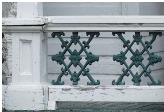
Nicolet compte encore quelques garde-corps dont les barreaux sont en fait des éléments découpés en fonte moulée. On en retrouve une grande variété de modèles, dont celui-ci au 391, rue de Monseigneur-Plessis. IMG_0254.jpg
