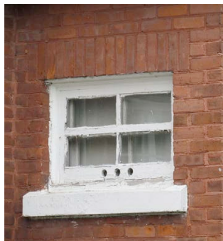
Exemple de fenêtre fixe à petits-bois éclairant le porche du 147, rue de Monseigneur-Signay. IMG_0750.jpg
