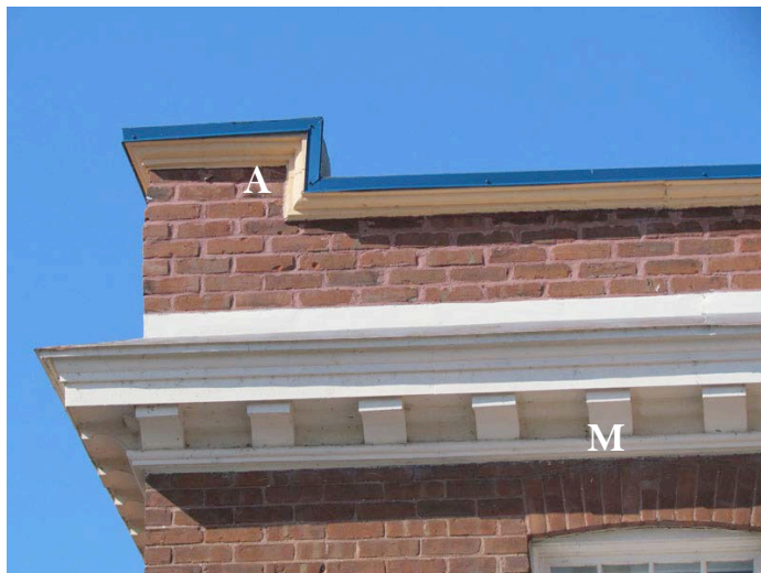
Amortissement (A) et corniche à modillons (M) au 316, rue Notre-Dame. IMG_1115.jpg
