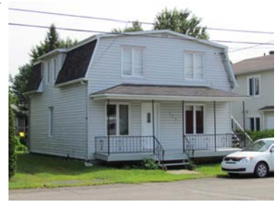
Valeur patrimoniale : Faible
