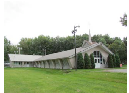
Exemple d'architecture religieuse, l'église dite Chapelle du Port-Saint-François au 2890, chemin du Fleuve Ouest. BIMG_1087.jpg
