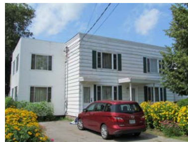
Valeur patrimoniale : Faible
