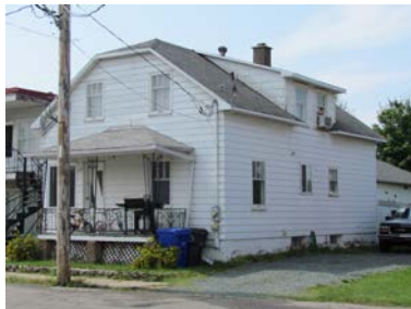
Valeur patrimoniale : Faible
