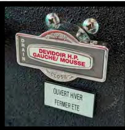
**L'été les drains des dévidoirs hautes pressions doivent rester fermés pour éviter de gaspiller la F-500.**
